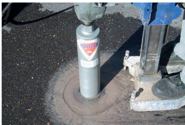
Figura 10. Disposición de la máquina extractora.
