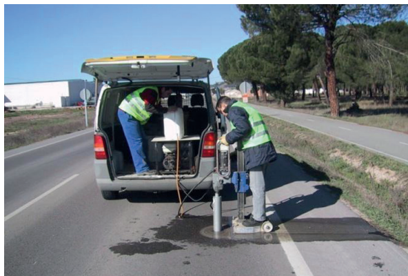
Figura 9. Toma de muestra de testigos de mezcla bituminosa.
