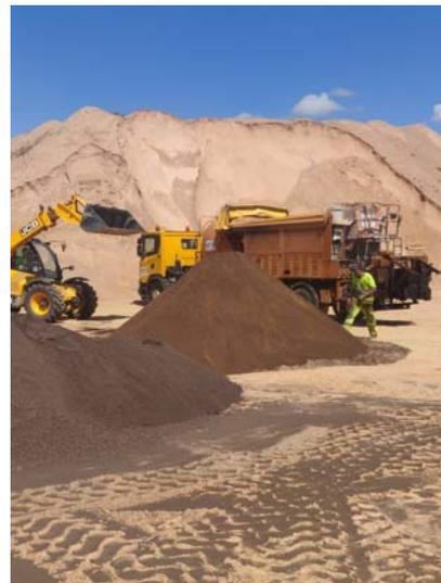
*Foto 4 y 5. Detalle del Fresado 0/6 mm tratado acopiado en planta.*
