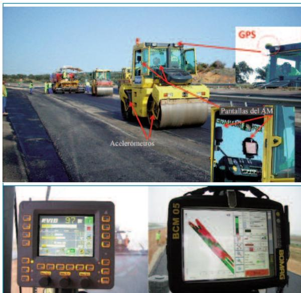
Figura 4. Bomag Asphalt Manager- Pantallas del sistema, la de control y con mapas de compactación
