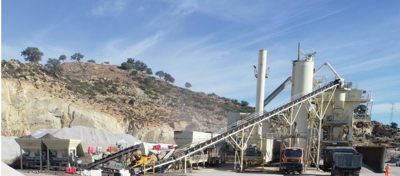
Planta asfáltica grupo Eiffage en Gerena (Sevilla)
