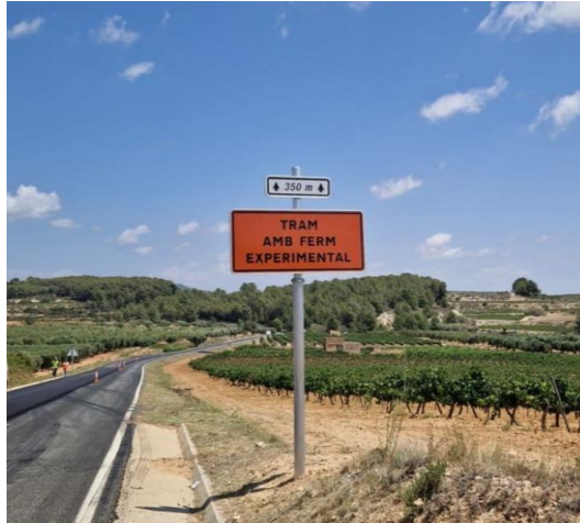
Puesta en obra de BIOPHALT®
