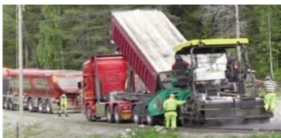
El nuevo camión se sitúa delante, alineado con la extendidora, eleva caja y queda en espera.
