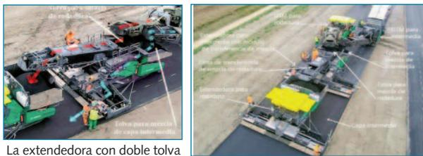
La extendidora con doble tolva y transferencia de mezcla de rodadura a extendidora posterior.
