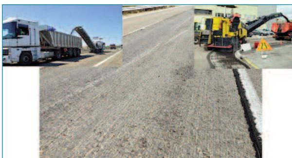
Figura 72. Fresado y reposición.
