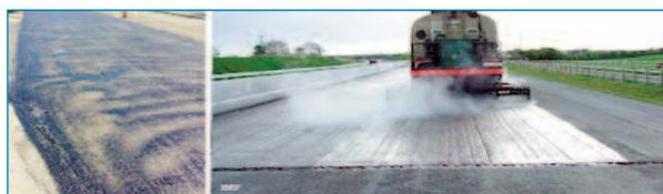
Figura 74. Riego con lanza y con rampa
