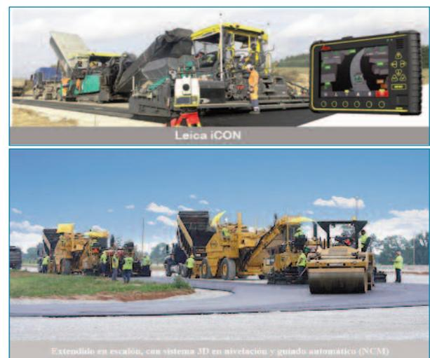
Figura 31. Extendido 3D con guiado automatizado.
