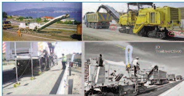
Figura 73. Sistemas de nivelación para perfil fresado.
