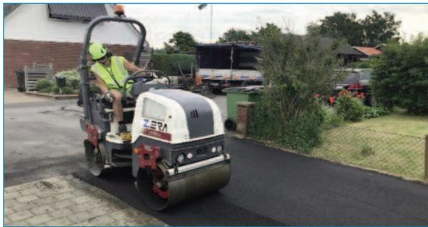
Figura 49. Compactador eléctrico CC900E de Dynapac.
