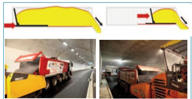
Figura 70. Caja push-off de Fliegl. Esquema y ejemplos de empleo.
