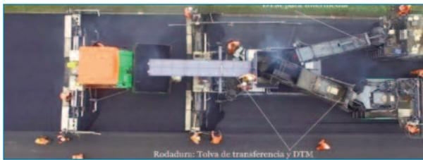
Proceso InLine con cuatro máquinas, un DTM para cada mezcla.
