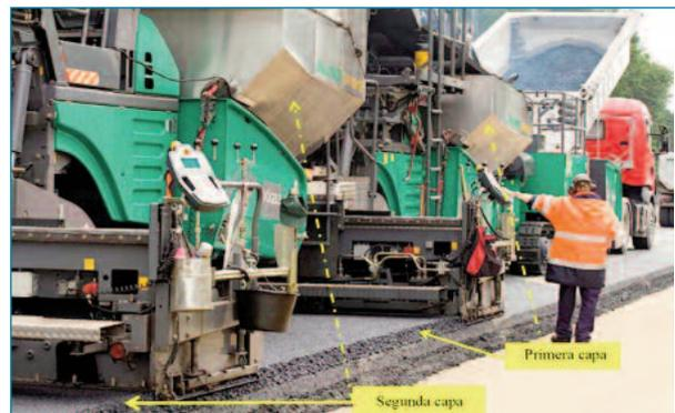
Figura 33. Vista de las dos capas sucesivas (InLine Pave, Vögele).
