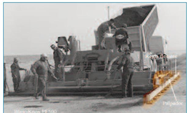
Figura 21. Blaw-Knox PF-500 con viga flotante.
