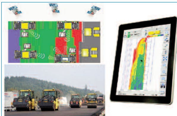
Figura 5. Compactación inteligente, en red
