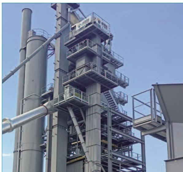
Imagen 11 Sistema de incorporación de fresado al mezclador.
