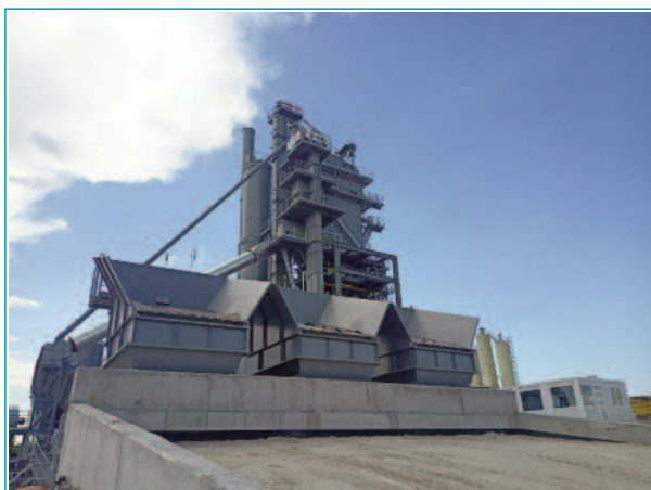
Imagen 8 Tolvas de alimentación de material fresado.
