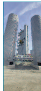
Imagen 15 Tanques de almacenamiento de ligante verticales.
