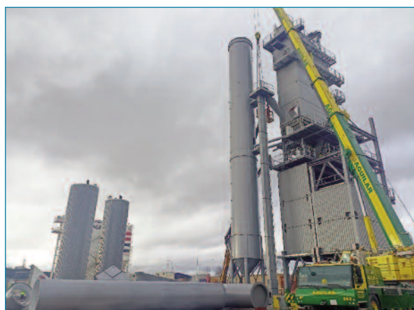
Imagen 6. Instalación de la planta.
