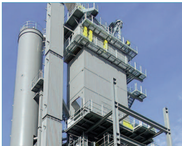
Imagen 14 Almacenamiento de áridos cribados y calientes en 2 líneas.
