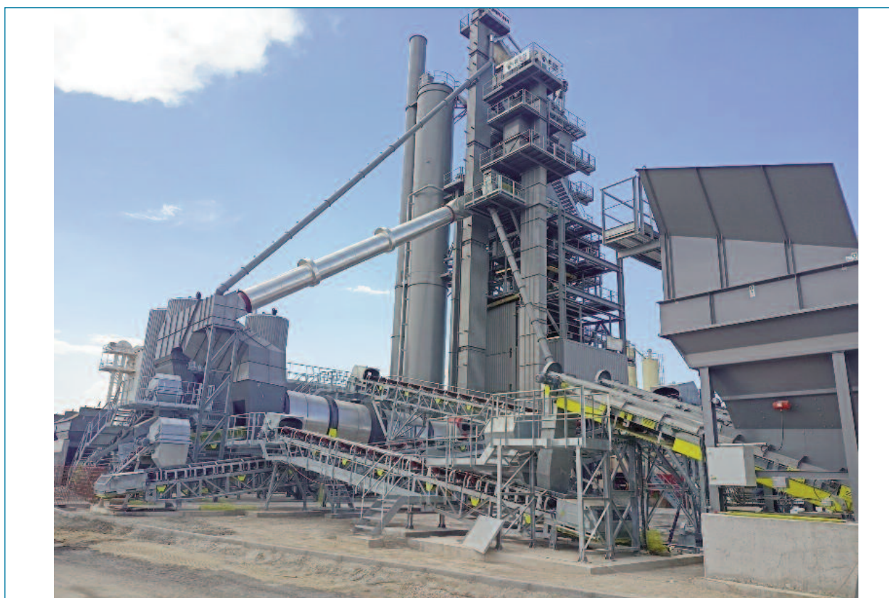
Imagen 1. Fotografía general de la planta.
