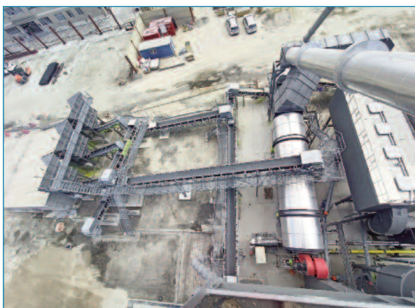
Imagen 5. Instalación de diferentes elementos de la planta.
