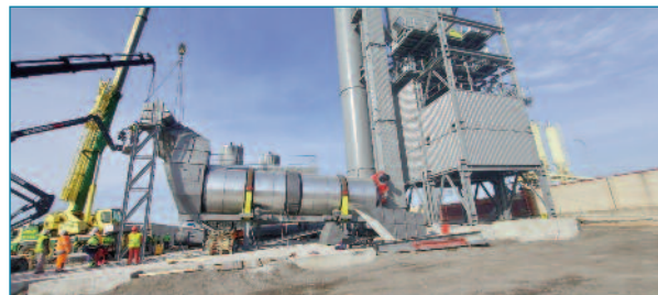
Imagen 3 Colocación del quemador de la planta durante el montaje.
