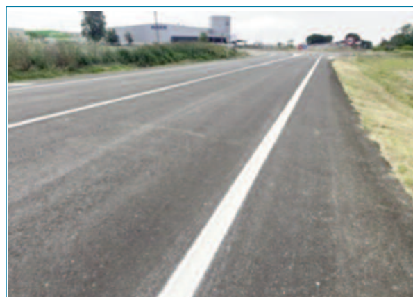
Figura 9. Capa de rodadura terminada
