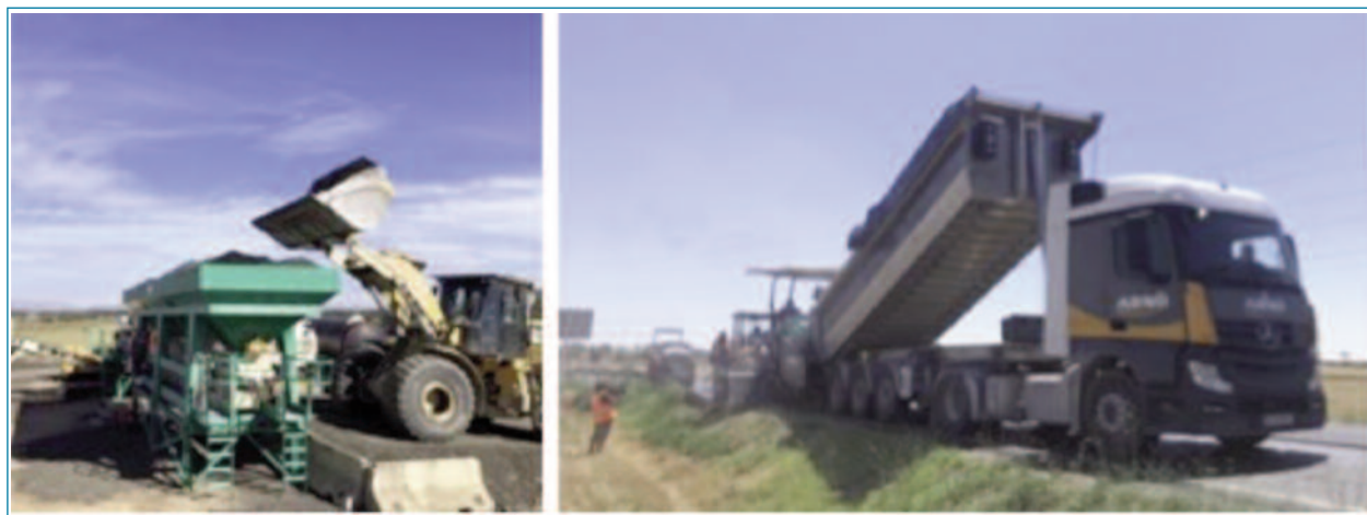
Figuras 3 y 4. Fabricación y puesta en obra de la mezcla reciclada en capa de rodadura
