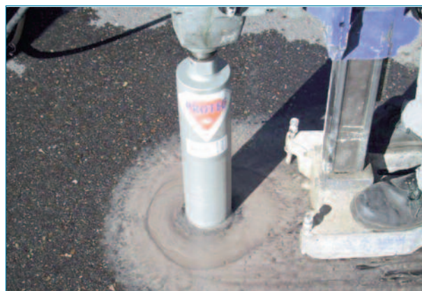
Imagen 4. Extracción de testigos.
