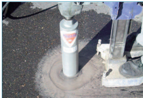
Imagen 4. Extracción de testigos.
