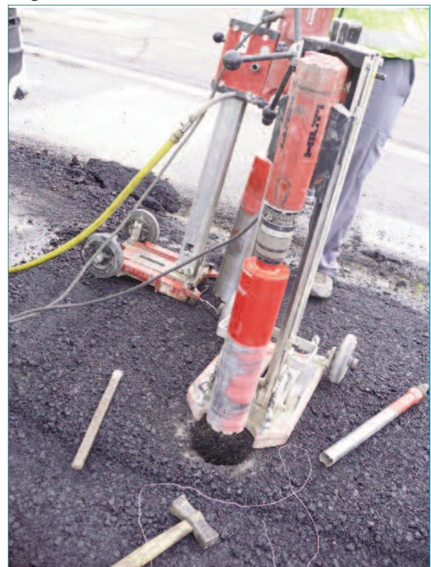
Imagen 3. Imagen extracción de testigos.
