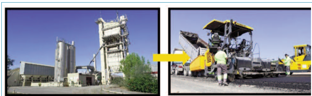
Figura 1. De la planta a la obra existen muchos pasos.
